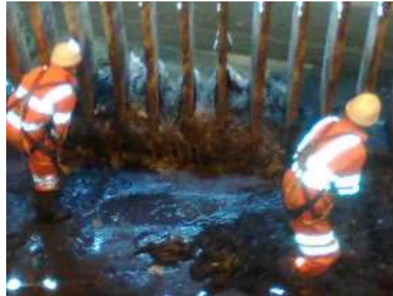
Rags blocking Detritor Inlet Vanes
